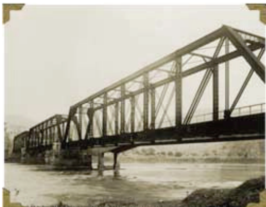
Ponte de ferro com arquitetura típica na rodovia “União Indústria”.
