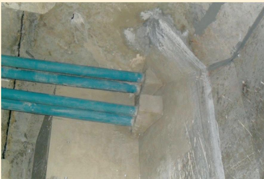
**FIG. 13 – REFORÇO DAS ADUELAS POR PROTENSÃO ADICIONAL NO INTERIOR DOS CAIXÕES DE CONCRETO, EM MOMENTO NEGATIVO (FONTE: ECOPONTE 2018)**
