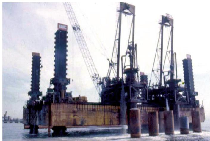
FIG. 27 – PLATAFORMA AUTO ELEVATÓRIA PARA A ESCAVAÇÃO E CONCRETAGEM DOS TUBULÕES BADE-WIRTH
