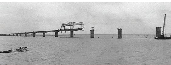
**FIG. 9 – PONTE DE OLÉRON (FRANÇA), EM EXECUÇÃO COM UMA TRELIÇA DE MONTAGEM**
