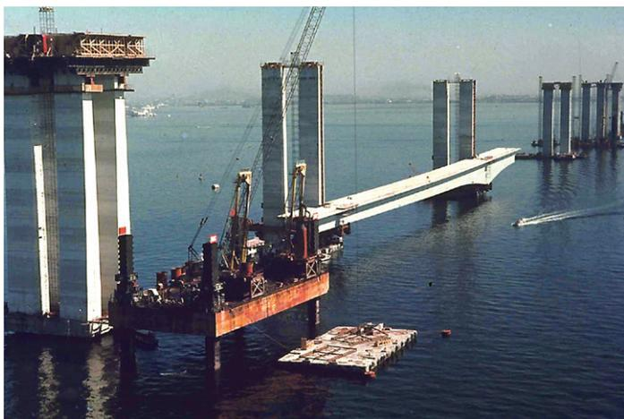
**FIG. 30 – INSTALAÇÃO DE UM VÃO DE 200M AO LADO DOS PILARES, AGUARDANDO O OUTRO VÃO LATERAL PARA A OPERAÇÃO SE SUSPENSÃO DOS 2 TRECHOS AO MESMO TEMPO. DO LADO ESQUERDO É MOSTRADO O VÃO MOLDADO IN SITU DE 12M COM PILAR PROVISÓRIO**
