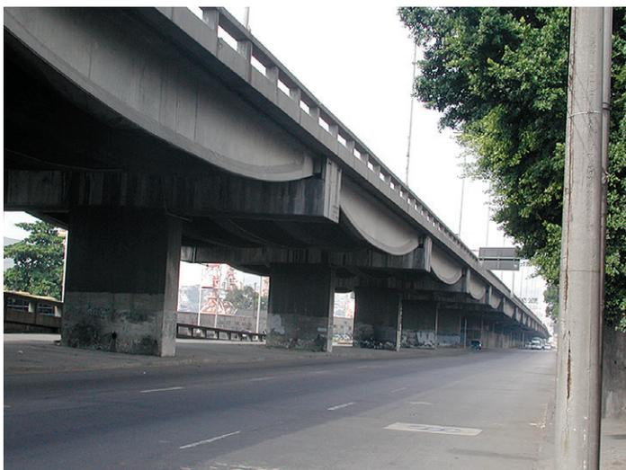
FIG. 6 – A ESTRUTURA COM AS BARRIGUDAS É ADEQUADA ESTETICAMENTE
