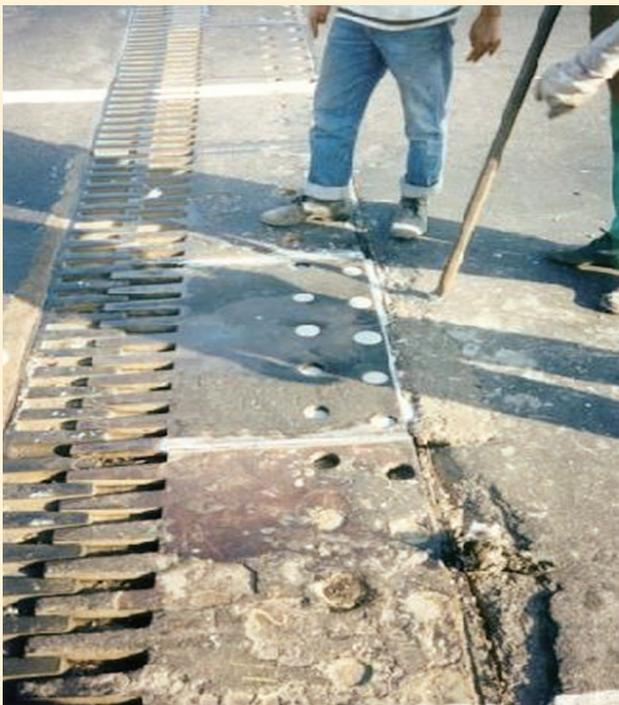
**FIG. 3 – DEFEITOS EM JUNTAS DE DILATAÇÃO TIPO FT 200, ORIGINÁRIOS DO PERÍODO SEM MANUTENÇÃO, DE 1974 A 1979. (FONTE: RELATÓRIO DE VISTORIA DA PONTE – 1990)**
