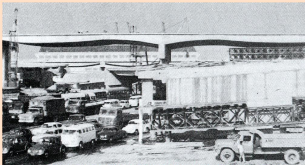
**FIG. 7 – ASPECTO DA VIGA CONTÍNUA, PARCIALMENTE PRÉ-FABRICADA, USANDO LONGARINAS TIPO B E CONCRETO LOCAL [10]**
