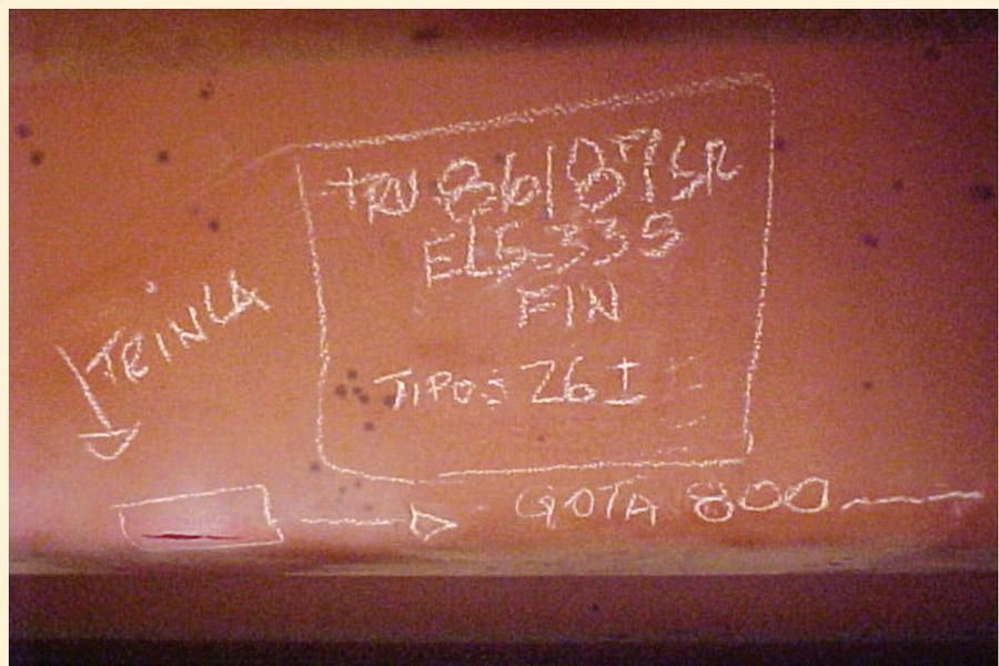
**FIG. 6 – TRINCA NO METAL DE BASE DO ENRIJECADOR LONGITUDINAL SUPERIOR 335, ENTRE TRANSVERSINA 86/87, NO CAIXÃO SUL RIO. (FONTE: RELATÓRIO DE VISTORIA – 1993)**
