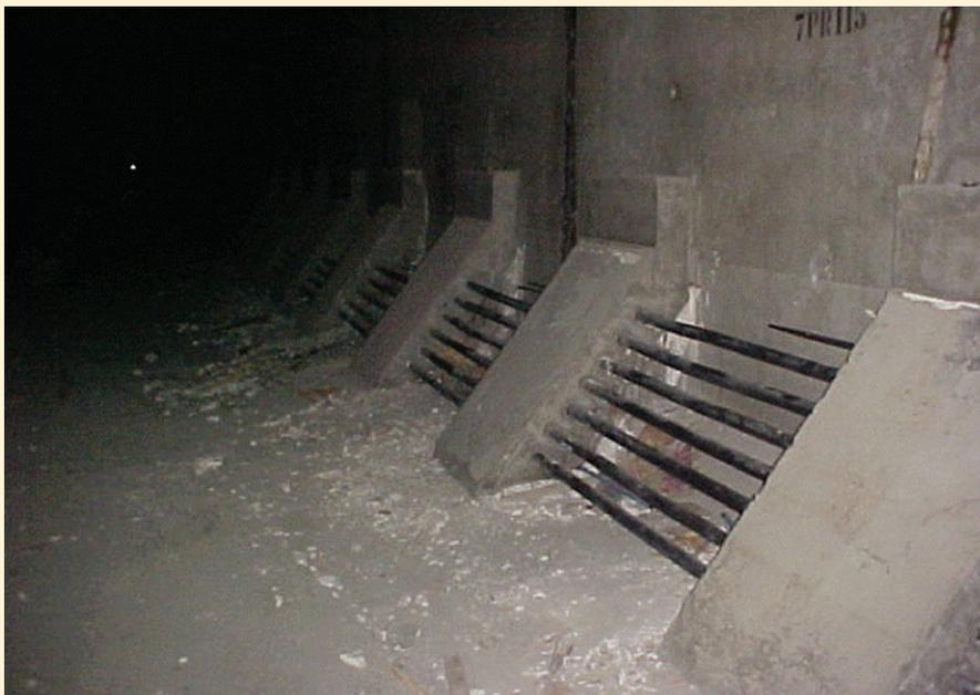
**FIG. 12 – REFORÇO DAS ADUELAS POR PROTENSÃO ADICIONAL NO INTERIOR DO CAIXÃO DE CONCRETO EM MOMENTO POSITIVO (FONTE: PONTE S/A – 2005)**
