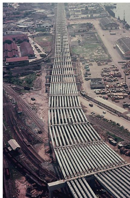
FIG. 7 – VIGAS PRÉ-MOLDADAS DO ACESSO RIO. O TRECHO DA PARTE SUPERIOR DA FIGURA ESTÁ SOBRE A AV. RIO DE JANEIRO EM ÁREA DO PORTO CARIOCA
