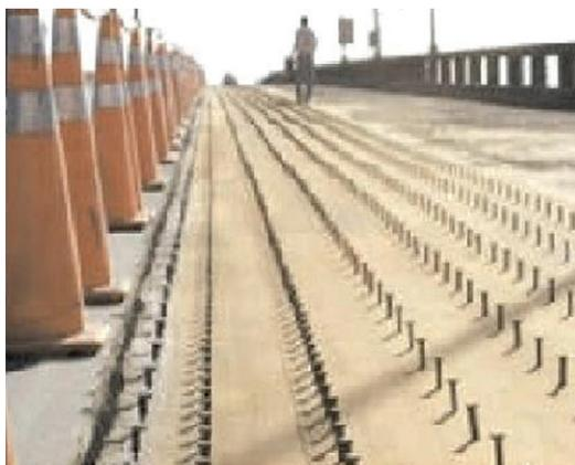
**FIG. 33 – CONECTORES UNINDO A CHAPA HORIZONTAL A UMA CAMADA DE CONCRETO, UM PROJETO DO MARIO VILA VERDE**
