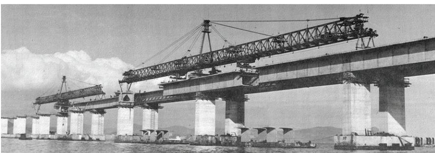
**FIG. 12 – VISTA DE 2 TRELIÇAS DE MONTAGEM EM FUNCIONAMENTO**
