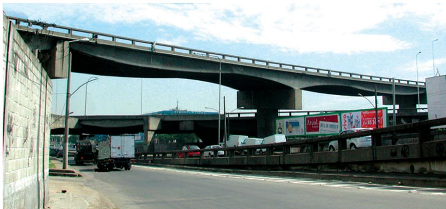
**FIG. 25 – A VIGA CONTÍNUA DE 2 VÃOS DE CONFORMAÇÃO GEOMÉTRICA ADAPTADA AO DIAGRAMA DE MOMENTO FLETORES. OS DOIS VÃOS EM PLANTA ESTÃO EM CURVA. PROCUROU-SE ADOTAR O PROGRAMA STRUDL DE ELEMENTOS FINITOS, MAS NÃO SE TEVE SUCESSO NA ÉPOCA**
