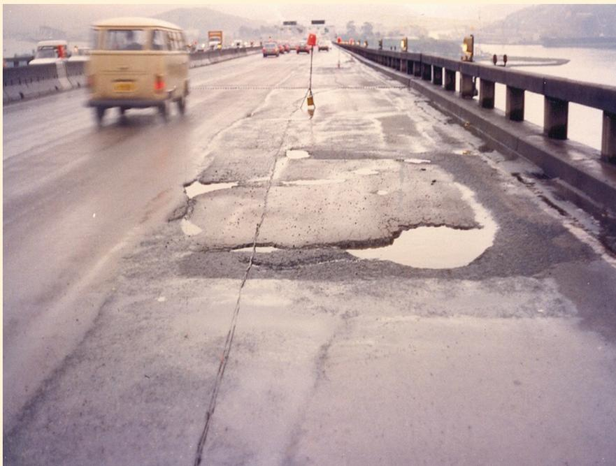
**FIG. 1 – DEFEITOS NA PAVIMENTAÇÃO SOBRE OS VÃOS METÁLICOS DURANTE PERÍODO DE CHUVA (FONTE: CONSÓRCIO NORONHA/HNTB – 1986)**
