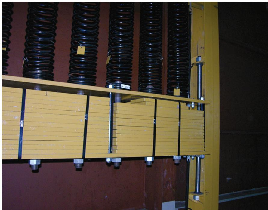
FIG. 37 – ESTRUTURA COM ADS (ATENUADORES DINÂMICOS SINCRONIZADOS): PROJETO DE RONALDO BATTISTA
