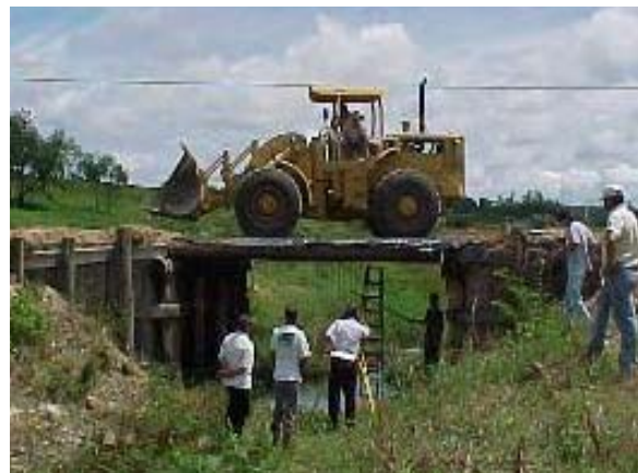
Figura A34 – Prova de carga sem o concreto
