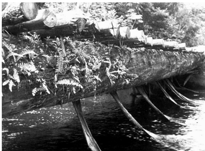
Figura 4.1 – Ponte em vigas roliças
