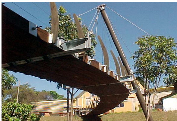
Figura A41 – Vista inferior do tabuleiro
