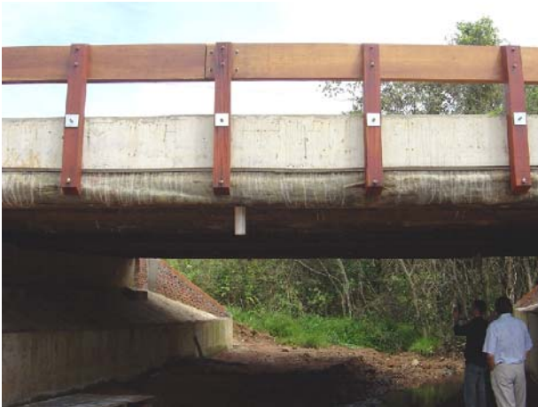
Figura A47 – Vista lateral da ponte
