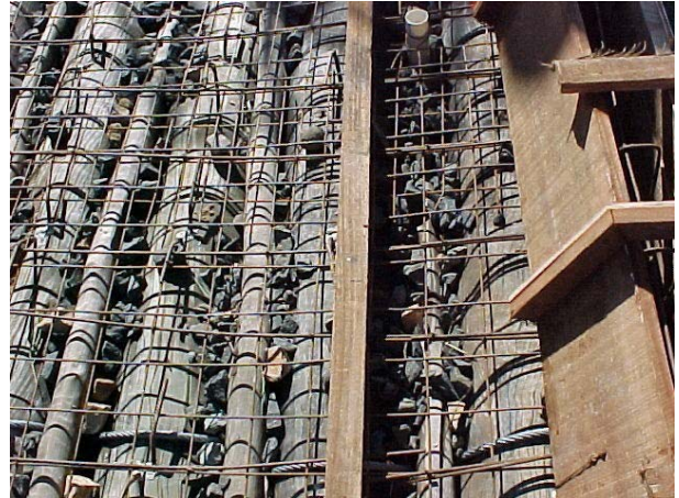
Figura A30 – Vista das ferragens do tabuleiro
