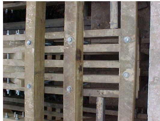
Figura A5 - Fixação das transversinas
