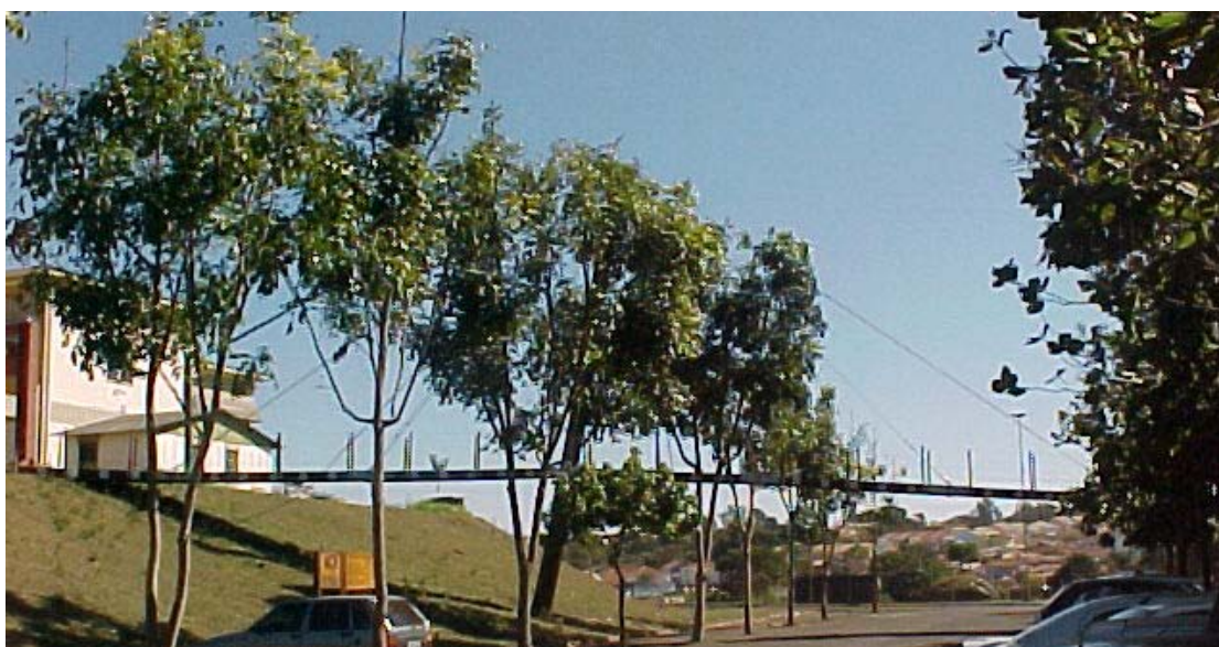
Figura A40 – Vista da Passarela Estaiada em Módulos Curvos
