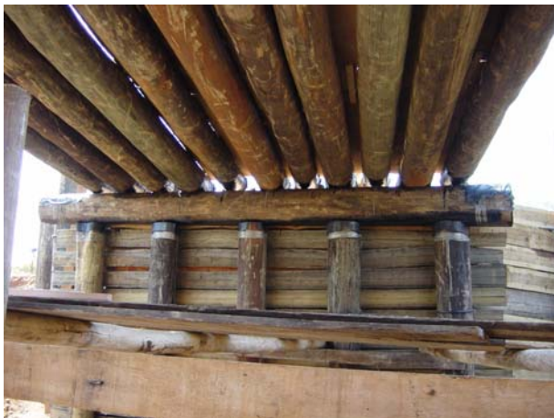
Figura A35 – Posicionamento das longarinas
