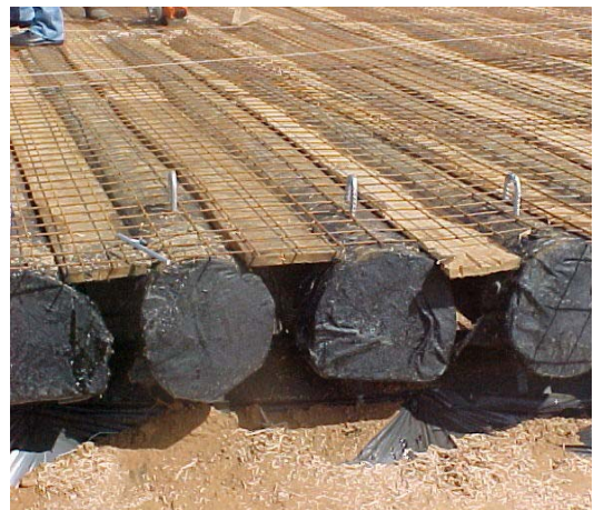
Figura A36 – Detalhe de proteção dos tops
