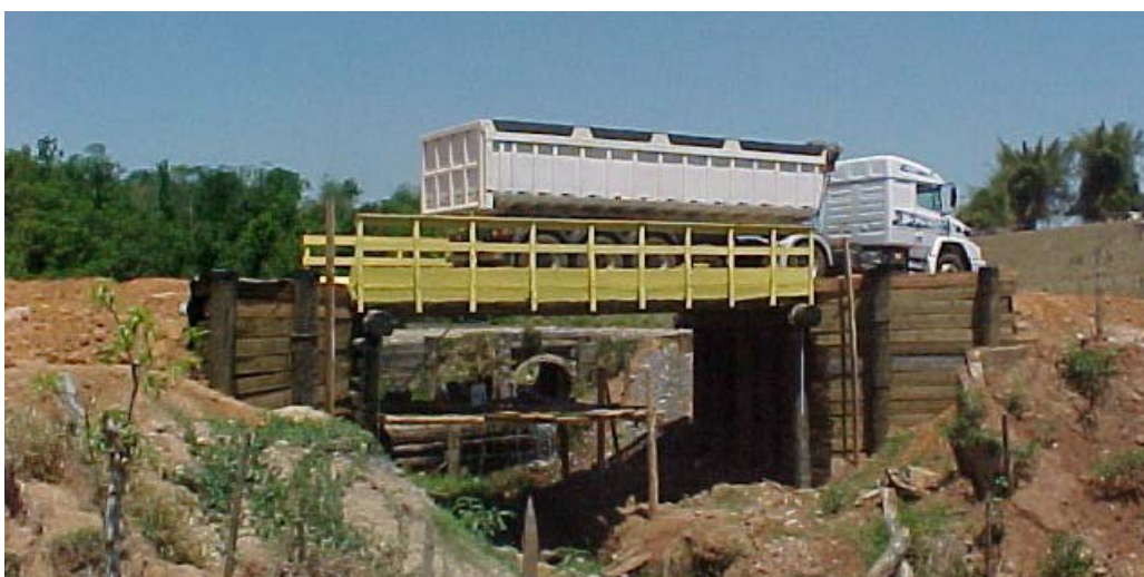
Figura A38 – Vista da Ponte Paredão Vermelho
