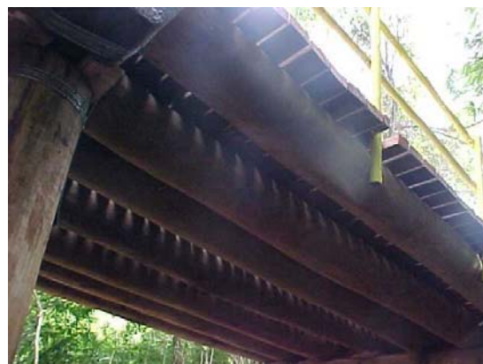
Figura A26 – Vista inferior do tabuleiro
