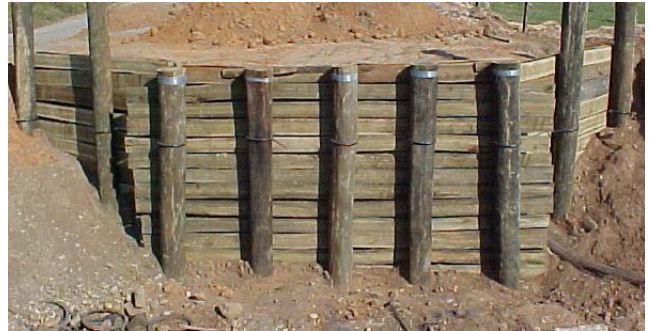
Figura A34 – Fundação concluída
