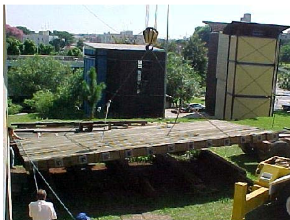
Figura A41 – Transporte do tabuleiro
