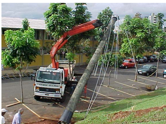
Figura A43 – Içamento do mastro
