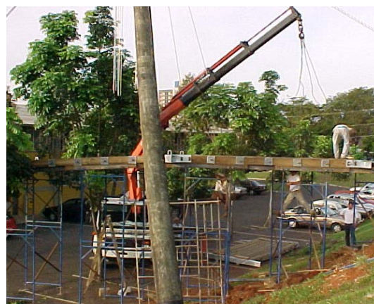
Figura A44 – Içamento dos módulos
