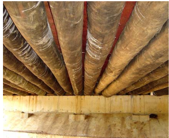
Figura A48 – Vista inferior do tabuleiro
