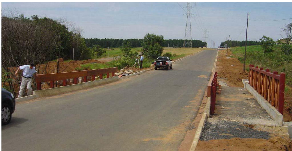
Figura A46 – Vista da Ponte 01
