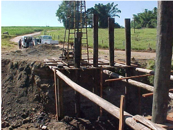
Figura A33 – Cravação das estacas
