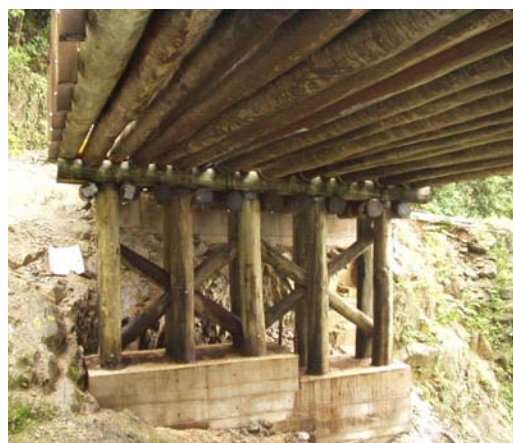
Figura A14 – Vista inferior do tabuleiro
