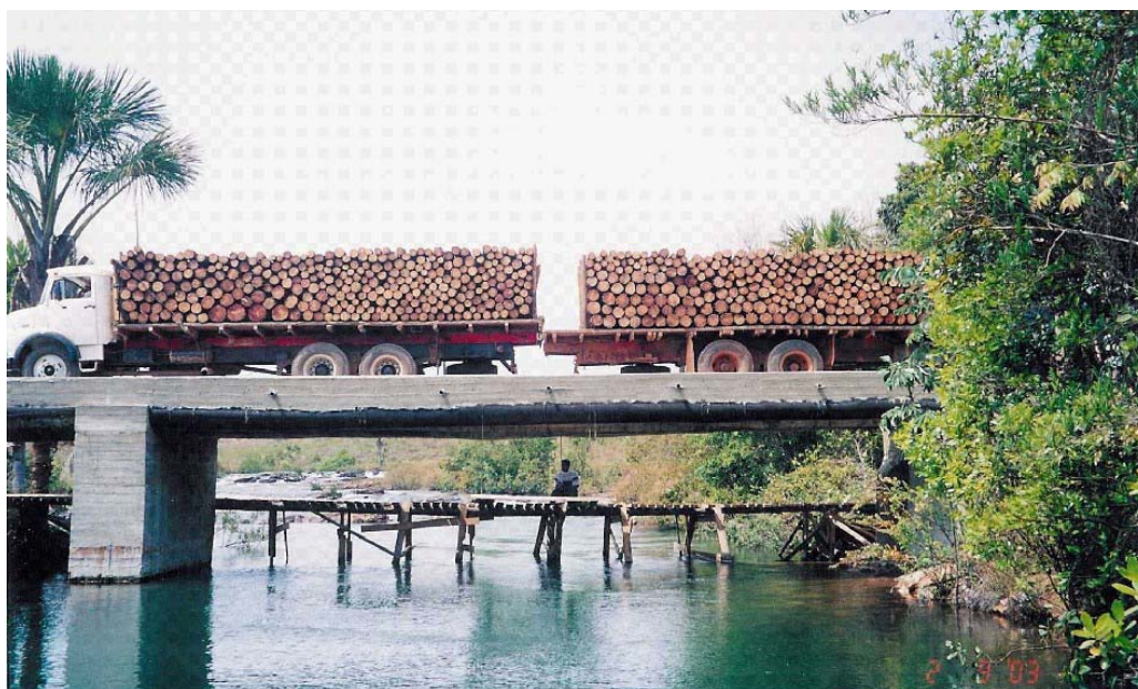
Figura A11 – Prova de carga no vão maior com dois veículos
