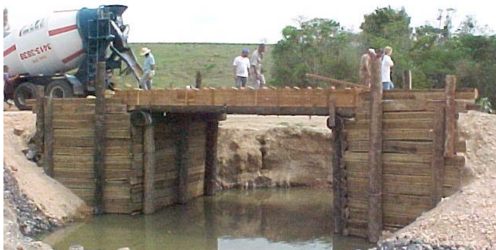
Figura A18 - Vista da Ponte Capela
