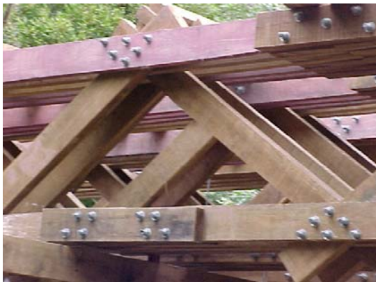
Figura A4 - Detalhes das ligações
