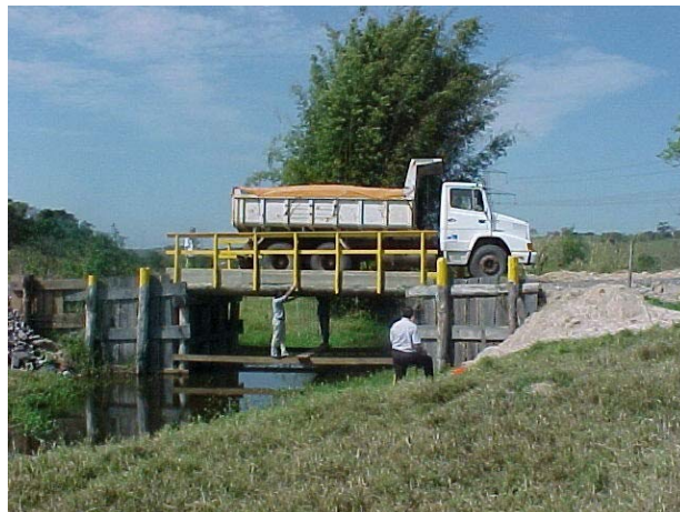
Figura A31 – Prova de carga na ponte
