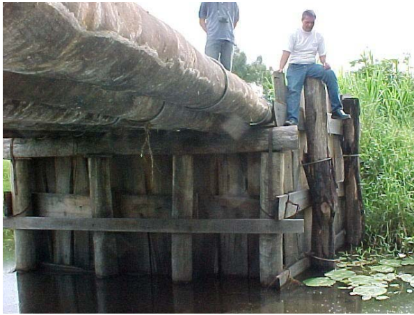
Figura A29 – Vista inferior do tabuleiro
