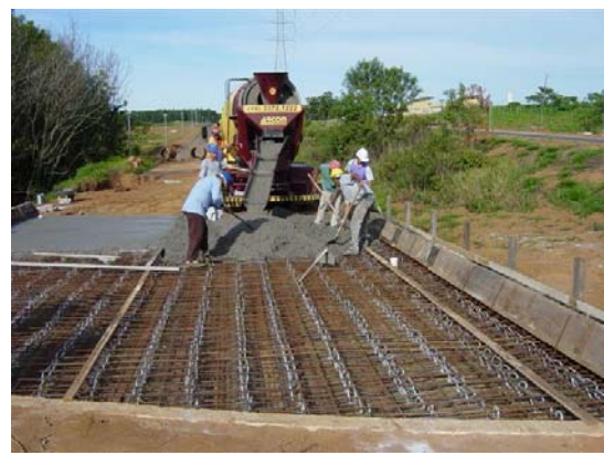
Figura A56 – Concretagem do tabuleiro
