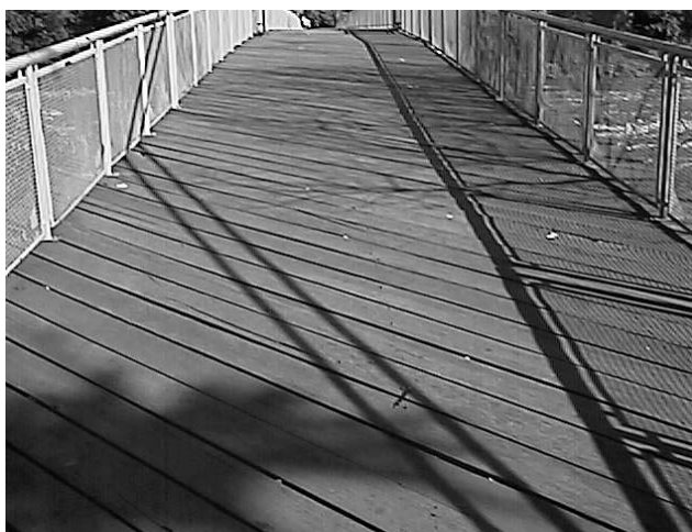
Figura 5.2 - Tabuleiros de pranchas cruzadas de madeira serrada (vista da camada superior)
