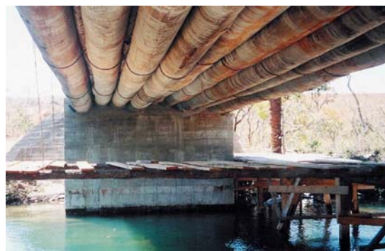
Figura A8 – Vista inferior do tabuleiro
