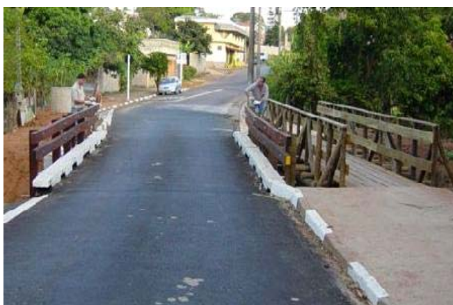
Figura A39 – Vista da ponte pronta
