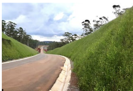
Fotos 5, 6 e 7: Taludes com aplicação de Hidrossemeadura sem nenhum tipo de preparo de solo ou coveamento.
