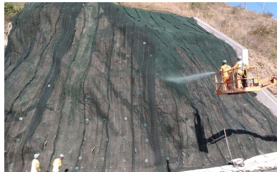
Foto 12: Solo verde grampeado recebendo aplicação de hidrossemeadura.
