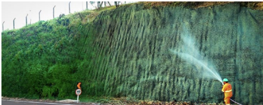
Foto 13: Junção de 2 fotos mostrando (à esquerda) obra de solo verde grampeado já com vegetação estabelecida e (à direita) recebendo aplicação de hidrossemeadura.
