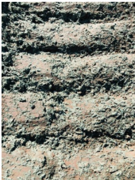
Hidrossemeadura ( 332 \text{ g/m}^2 )
