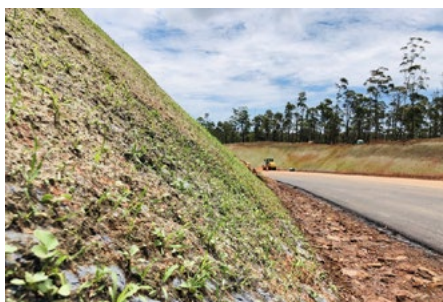
Fotos 5, 6 e 7: Taludes com aplicação de Hidrossemeadura sem nenhum tipo de preparo de solo ou coveamento.
