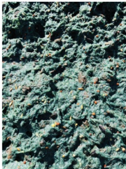
Hidrossemeadura ( 540 \text{ g/m}^2 )
